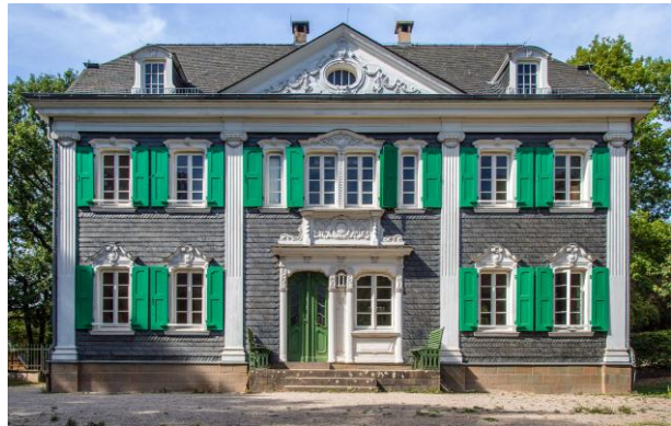
Haus Mannesmann in der Baugruppe Bergisches Land
